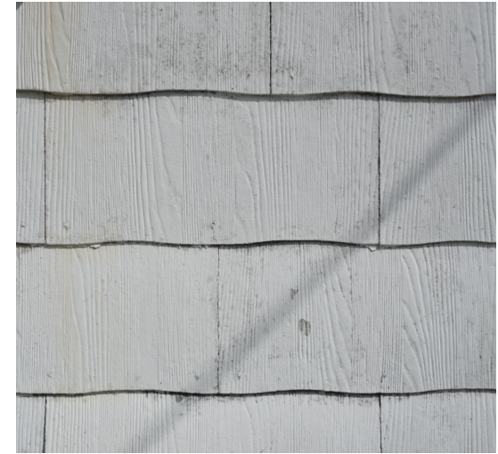
Asbestos Siding
